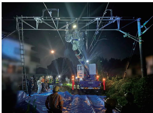
図 6.11 JR西日本和歌山線での初作業 2024年7月20日 (写真提供：西日本旅客鉄道株式会社)
