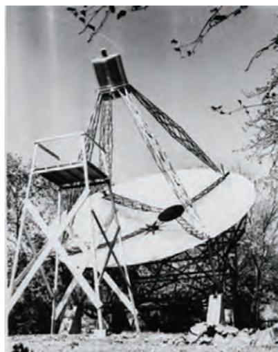
図 3.6 レーバーが自作したパラボラ電波望遠鏡
