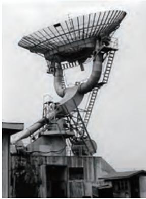
東京天文台三鷹 10 m 太陽電波赤道儀望遠鏡 (3 GHz, 1953 年頃)
