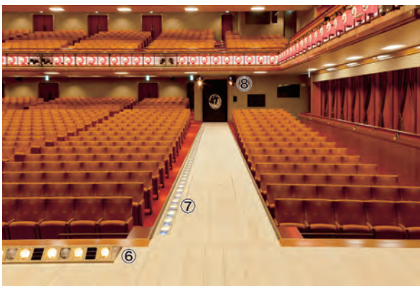
図 2.14 花道の舞台照明設備 14)
