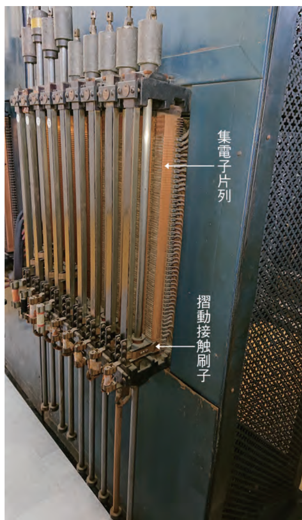
図 5.11 U型多分岐式調光変圧器の集電子片列と 摺動接触刷子 11)
