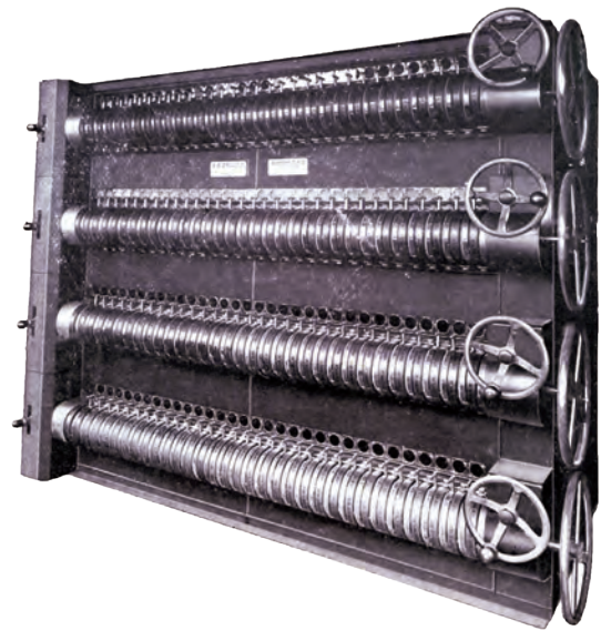
図 4.34 歌舞伎座の NW 型抵抗式調光器 34)
