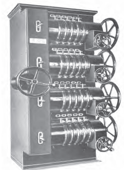
図 5.24 MDS-TF 型調光操作盤 (1960 年頃) 24)
