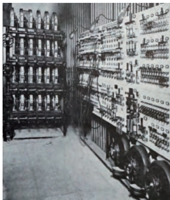
図 4.22 名古屋市公会堂の照明操作室 22)
