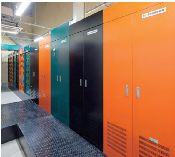
図 2.17 定式幕の色に塗装されたサイリスタ調光器盤 17)
