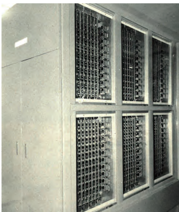
図 8.7 強電クロスバー盤 7)
