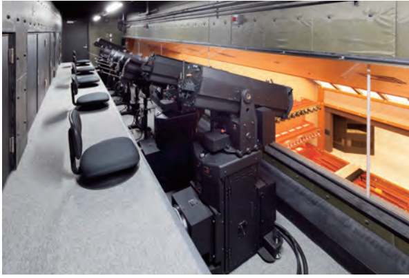
図 2.12 センターフォロースポットライト室の内部 12)
