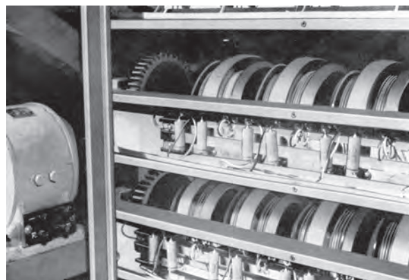
図 5.37 UM 型調光操作盤機構 37)
