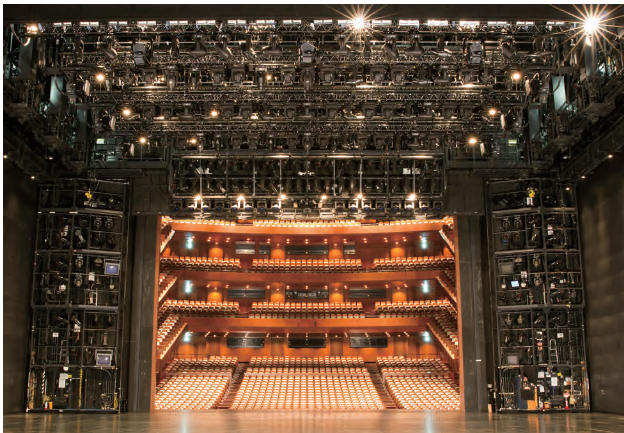
図 2.27 ポータルブリッジとポータルタワー 27)
