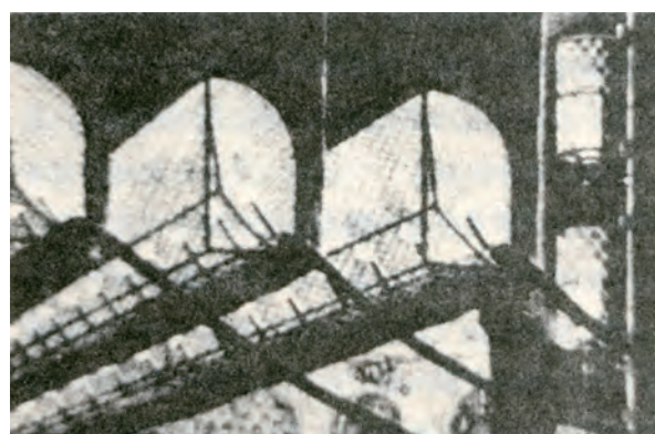
図 3.28 ガスバッテン (ボーダーライト) 28)
