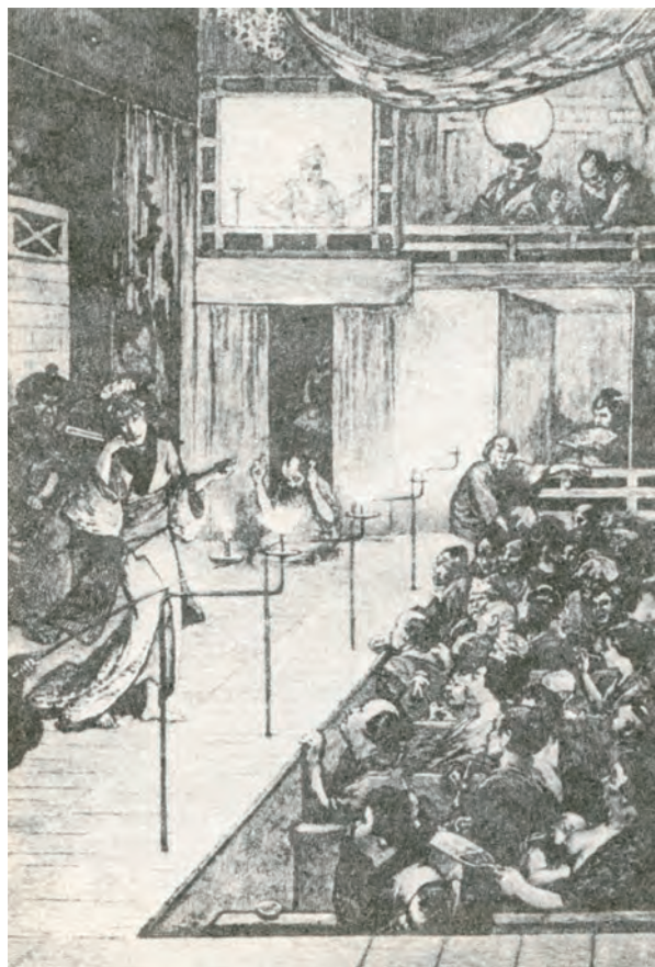
図 3.29 横浜湊座舞台のガス灯 29)
