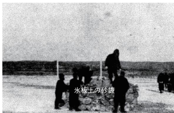
図4.9 氷上砂袋荷重試験<sup>4-5)</sup>: 自然結氷板上に砂袋30kg/個を最大40tonまで載荷し、氷厚(34~98cm)、載荷重、沈下量(3.2~14.0cm)、載荷時間(4~8時間)の関係を調べた。
