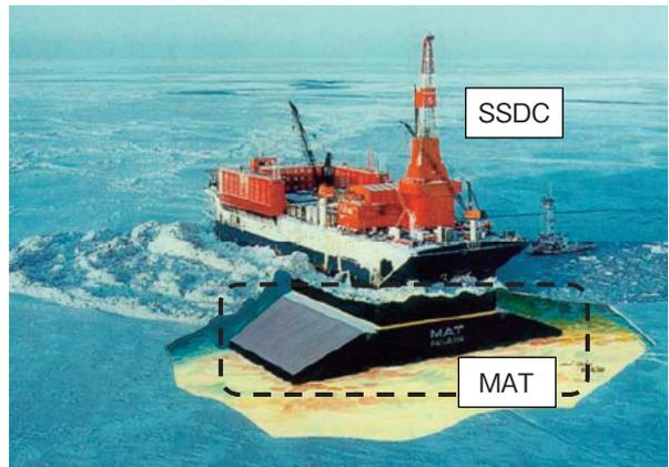
図8.10 氷海でのMAT/SSDCの概要図<sup>8-1)</sup>:海底地盤作業が大幅に削減されると共に、流水からの水力に対する抵抗力が向上した。
