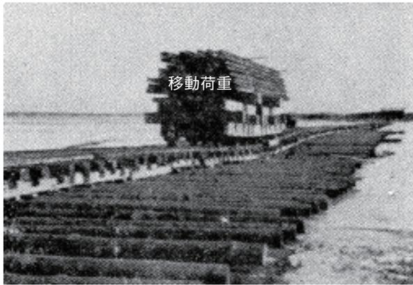
図 4.11 氷板移動荷重試験<sup>4-5)</sup>：氷板上に試験用の軌道を敷設し、列車荷重を想定した荷重を移動させ結氷板に与える影響を調べた。実際の機関車や貨車による列車走行試験の前段階としてこのような予備試験でデータの収集を行った。
