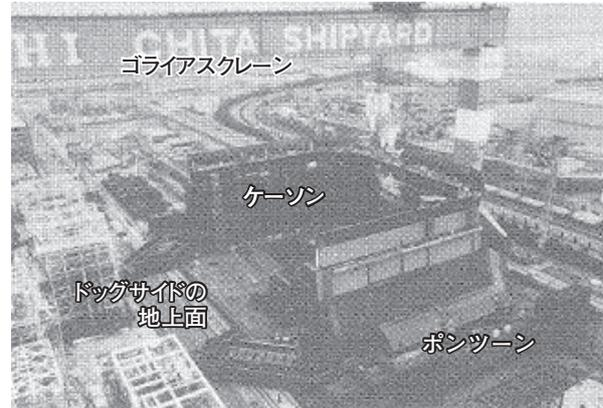
図 8.14 IHI 愛知工場で建造中の Molikpaq<sup>8-3)</sup>: ケーソン幅 111 m がドック幅 92m を超えているため、ケーソン左側がドックからはみ出ている。
