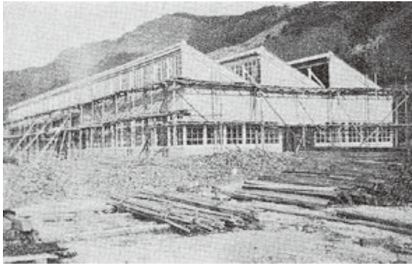
図 3.8.7 建設中の光洋精工国分工場（1937 年） 11)
