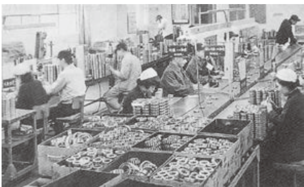
図 3.8.13 光洋精工完成品検査場 (1960年ごろ) 11)
