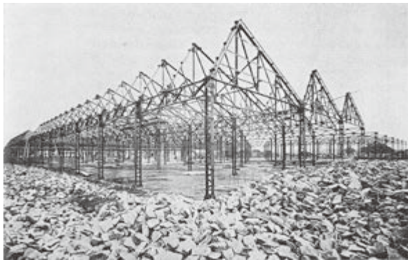
図 3.8.8 建設中の日本精工藤沢工場（1938 年） 9)
