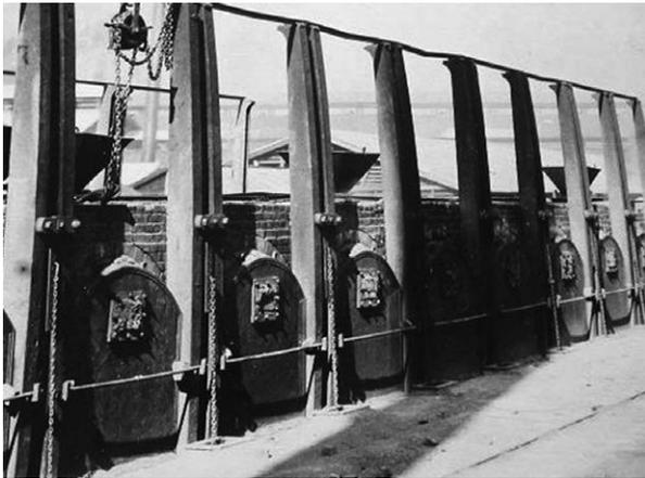
図 5.1 釜石コペー式コークス炉
