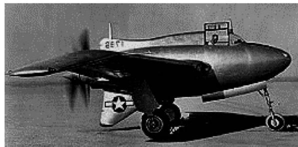
図 3.50 初めてのティグ溶接航空機（マグネシウム製 XP-56）<sup>1)</sup>
