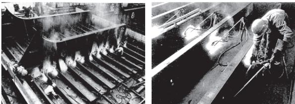
図 3.17 造船におけるグラビティ溶接<sup>6)</sup>
