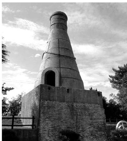
図2.8 太平洋セメント(株)小野田工場に残る豎窯(徳利窯)<sup>7)</sup>
