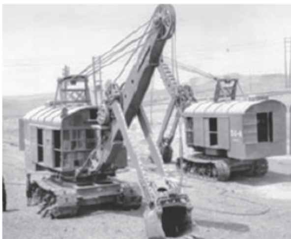
図 3.2 神戸製鋼所 50K 電気ショベル (1930)
