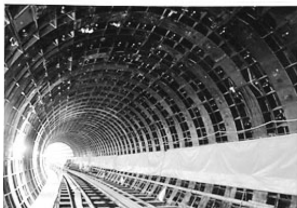
図 7.18 地下鉄工事に使用されたトンネルセグメント、(上) とトンネルの全景、(下) 昭和 40 年 (クボタ) 22)
