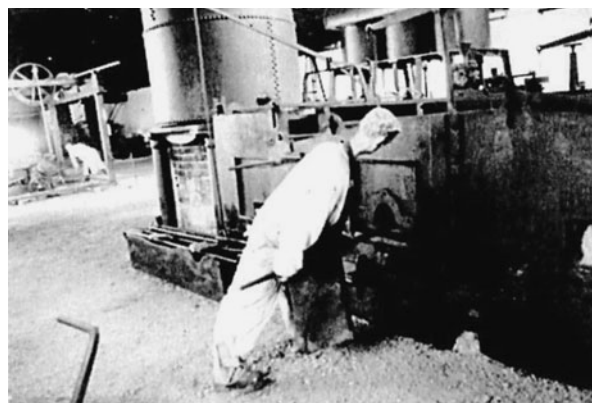
図3.5 世界で唯一残るパドル炉 16)
