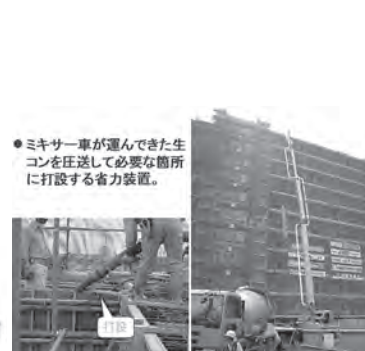
図 4.174 コンクリートポンプによる打設 (13)
