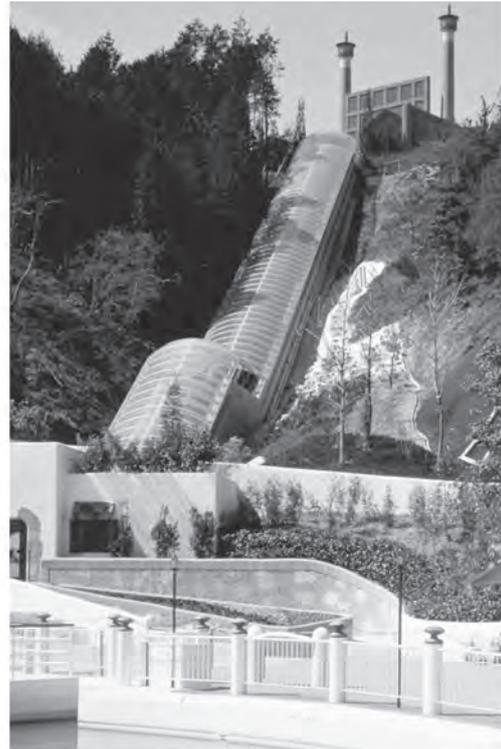
図5.21 レオマワールド超高揚程 中間踊場付き（ドーム内に設置）1200形 階高42m（1990年）三菱電機提供
