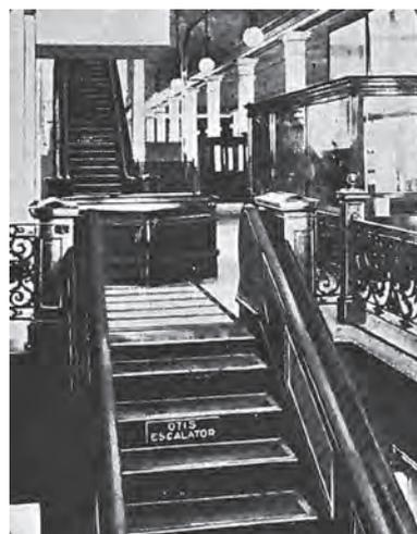
図 2.10 シーバーガー踏段式自動階段 上昇運転 2 方向横降り方式 (1910 年代) 日本オーチス提供
