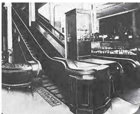
図 2.9 シーバーガー踏段式自動階段 下降運転 1 方向横降り方式 (1910 年代) 日本オーチス提供
