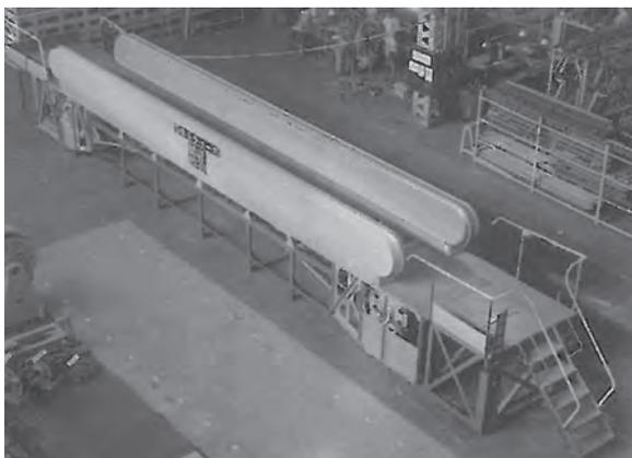
図7.1 動く歩道の試作機(1958年)三菱電機提供
