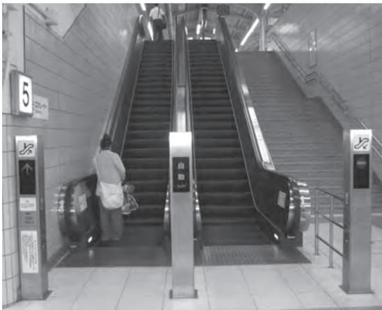
図4.12 光電装置による自動運転
