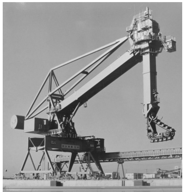
図3.55 石川島播磨重工業製 苫東コイルセンター 連続アンローダ 石川島運搬機械蔵
