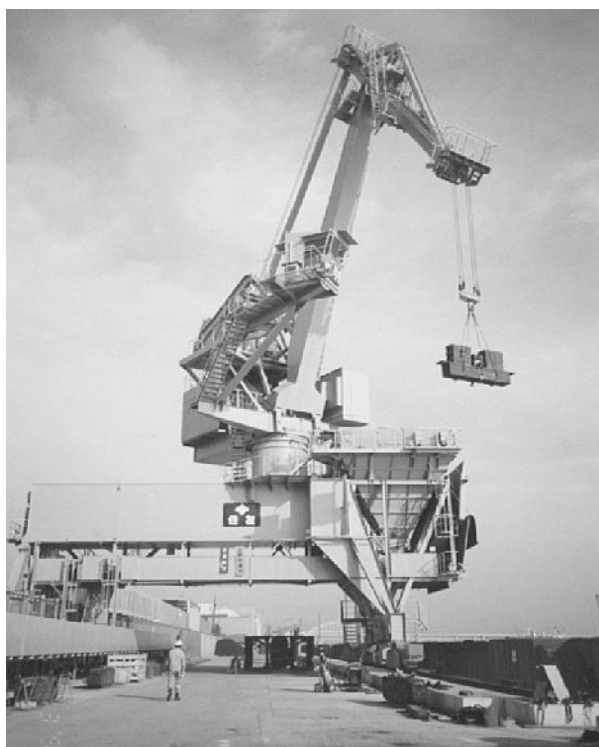
図3.30 神戸製鋼所横浜 水平引込クレーン 住友重機械エンジニアリングサービス蔵
