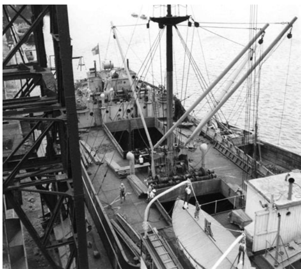
図3.3 船に設置されたデリック 新日本製鉄八幡製鉄所蔵
