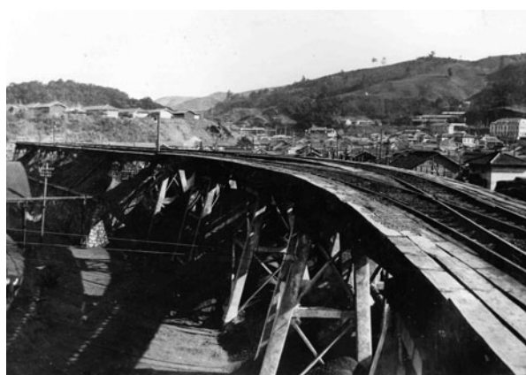
図3.10 貯炭場の高架橋 新日本製鉄八幡製鉄所蔵
