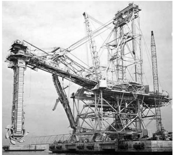
図3.51 三ツ子島 岩塩用連続アンローダ写真 石川島運搬機械蔵
