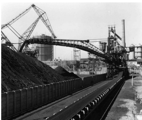
図3.32 八幡製鉄所戸畑スタッカ 新日本製鉄八幡製鉄所蔵
