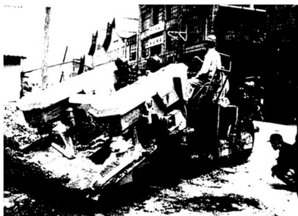
図3.35 フェースローダ 三井三池製作所蔵
