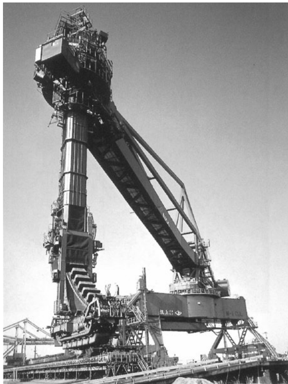
図3.57 福山製鉄所 連続アンローダ 石川島運搬機械蔵
