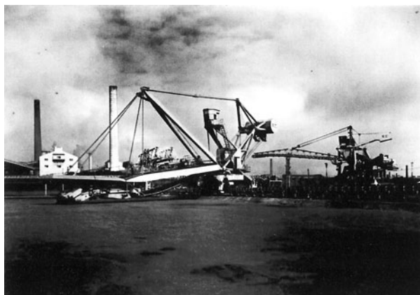
図3.36 三井鉱山のジブローダとスタッカ 三井三池製作所蔵
