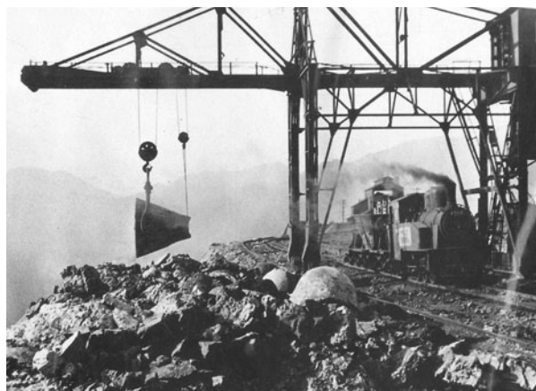
図4.1 釜石裏山で溶滓を投棄 出典：新日本製鉄釜石製鉄所編 「鐵とともに百年 [写真・資料]」 2
