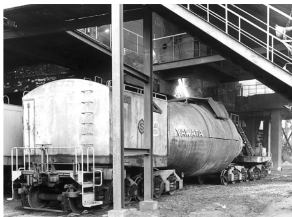
図4.8 新日本製鉄堺製鉄所250ton混銑車 新日鉄エンジニアリング所蔵
