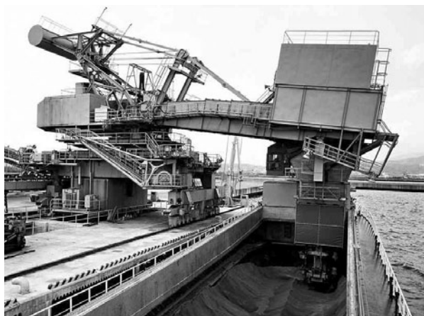
図3.53 大分製鉄所 連続アンローダ 住友重機械エンジニアリングサービス蔵
