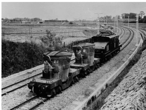
図4.20 八幡製鉄所 炭滓線 新日本製鉄八幡製鉄所蔵
