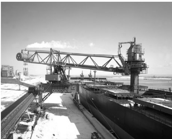
図3.56 住友重機械工業製 苫東コールセンター 連続アンローダ 住友重機械エンジニアリングサービス蔵
