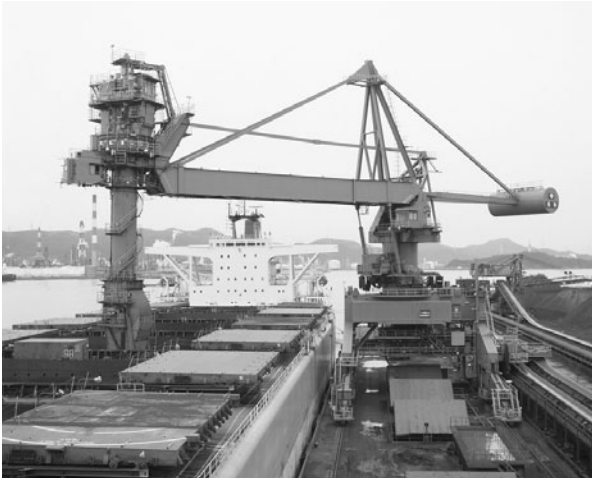
図3.62 水島製鉄所 連続アンローダ 住友重機械エンジニアリングサービス蔵
