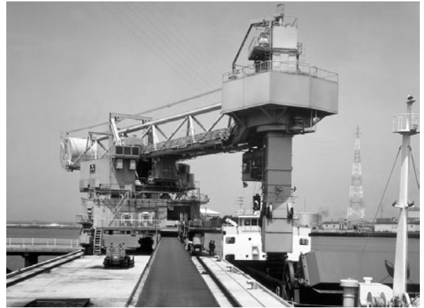
図3.54 四国電力西条火力発電所連続アンローダ 住友重機械エンジニアリングサービス蔵
