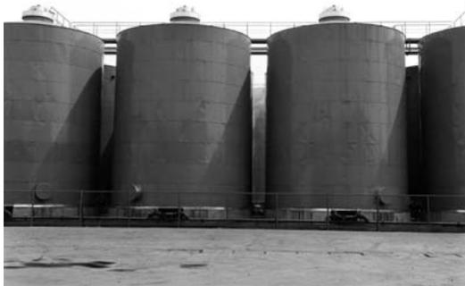
図5.20 屋外式大型鉄製タンク<sup>2)</sup>
