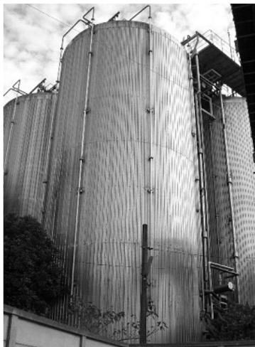
図5.22 屋外式大型スーパーステンレス製タンク<sup>51)</sup>
