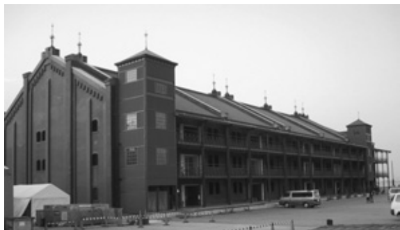
図3.7 横浜市の赤レンガ倉庫1号館（修復後）
