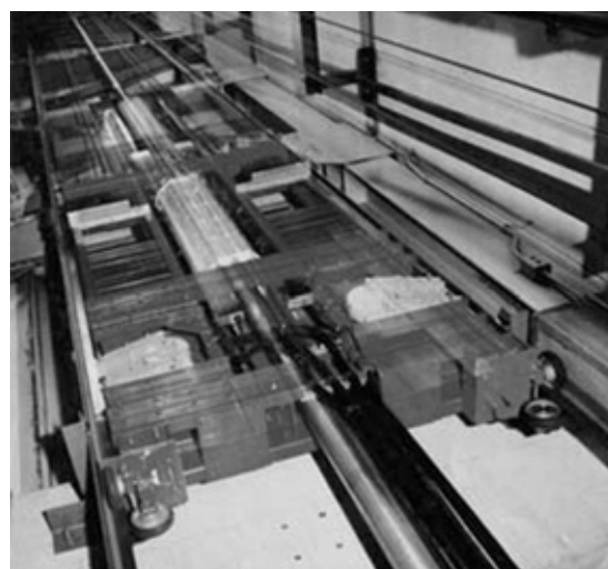
図5.22 つり合おりに組込まれたリニアモータ部とカラム（中央の円柱）
