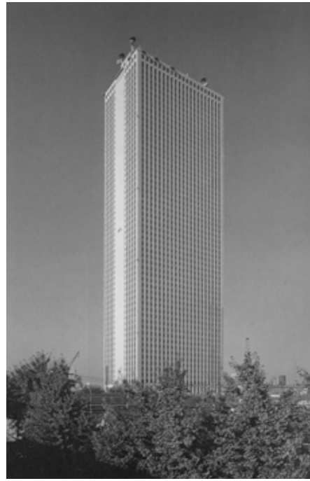
図5.9 600m/min超々高速エレベーターが納入されたサンシャイン60
