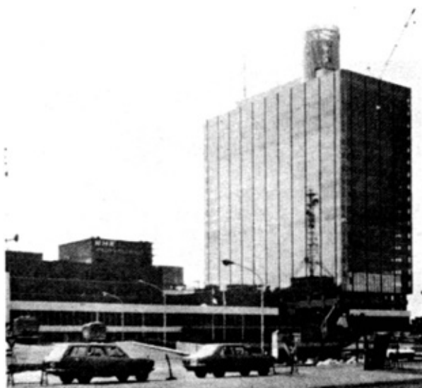
図5.11 建設中のNHK放送センタービル
