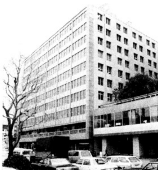
図4.11 本格的な群管理制御が話題となった 新三井ビル（大阪・中ノ島）
