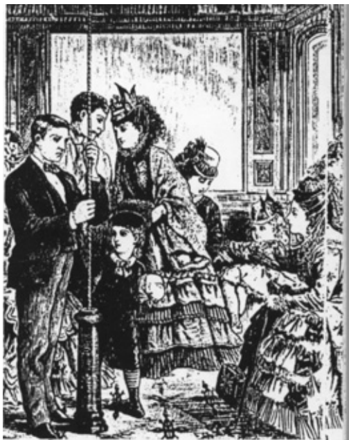
図3.3 ロープコントロール方式の運転の様子
