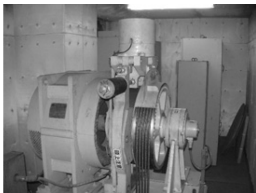
図5.17 120m/minインバータ制御高速ギヤレスエレベーターの巻上機
