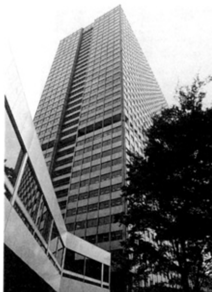
図4.7 初の超高速エレベーターが納められた霞が関ビル
