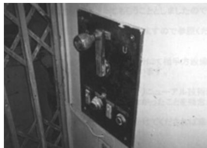
図3.26 カースイッチレバーとフォールディングゲートの一部
