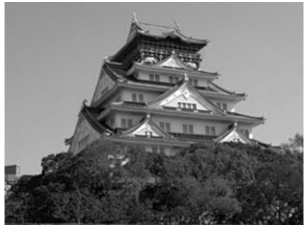
図3.14 大阪城には国産エレベーターが設置された
