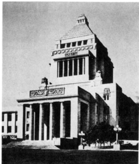
図3.16 国会議事堂には国産エレベーターが設置された
