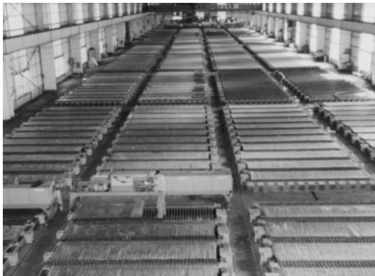
写真7.1 電解建屋内部
