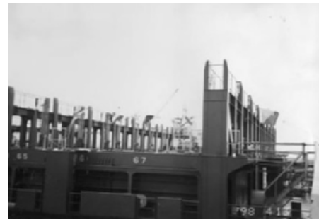
写真5.4 ラッシングブリッジ
