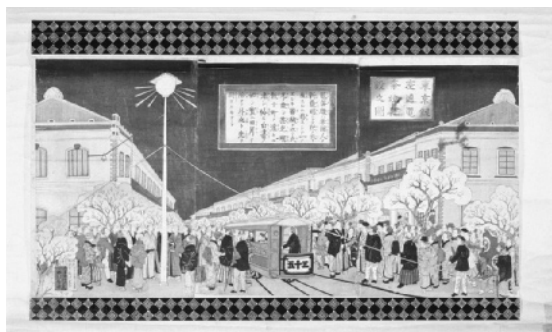
図2.4 『東京銀座通電気燈建設之図』 東京電力株式会社〔電気の史料館〕所蔵
