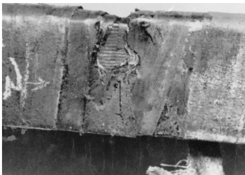
図6.12 アスファルトコンパウンド絶縁のガースクラックの例
