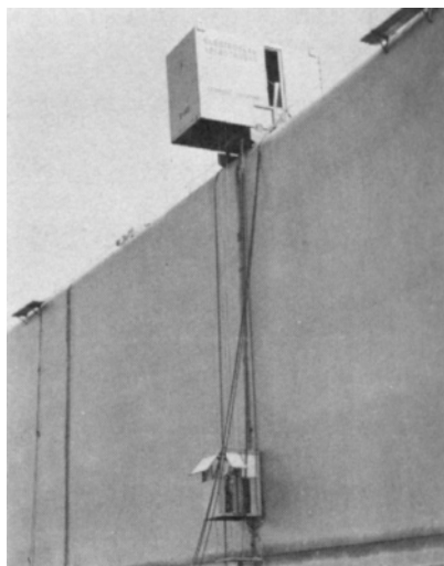
写真3.3.3 エレクトロスラグ溶接（造船の溶接—35年の歩み）
