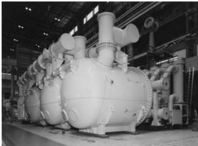
写真5.13 ガス冷却275kV 300MVA変圧器 東京電力東新宿SS向け (1994年 東芝製)
