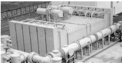
写真5.19 500kV直流リアクトル四国電力阿南変換所 (1997年 三菱製)
