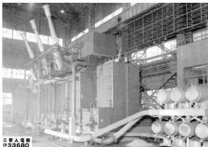
写真5.17 初の周波数変換用変圧器 電源開発佐久間FC (1964年 三菱製)
