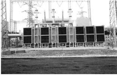
写真5.20 防音壁なしで60dBを達成した300MVA変圧器（東北電力石巻SS）
