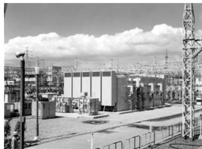
写真5.12 世界初の大容量ガス絶縁変圧器
