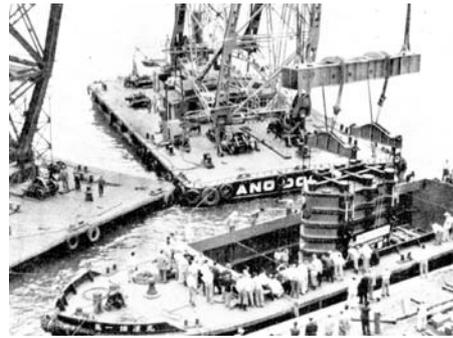
写真4.7 フローティングクレーンによる船積み 東京電力千葉PS向け 160MVA (1956年)
