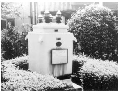
写真3.5 現存する最古の特別高圧変圧器（信濃電気 13.2kV 100kVA 1910年 芝浦製）
