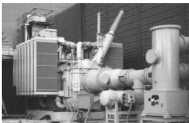
写真6.2 低ガス圧ガス絶縁変圧器 東北電力柳津西山PS 161kV 68MVA (1994年 東芝製)
