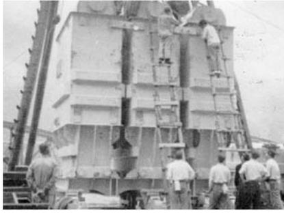
写真4.4 初の特別三相変圧器 電源開発佐久間PS向け 93MVA (1955年 三菱製)
