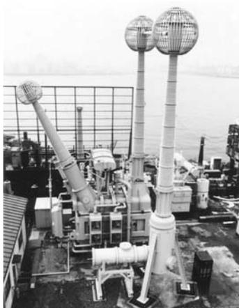
写真5.1 UHVプロトタイプ変圧器 (1979年 東芝製)
