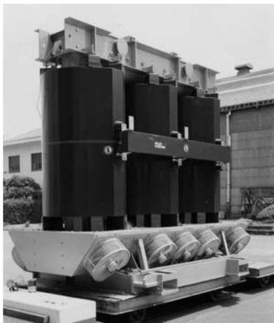
写真5.11 東京都向け22kV 13MVA モールド変圧器 (1994年 富士製)
