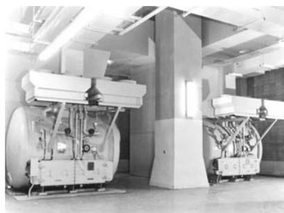
写真5.8 わが国初のガス絶縁変圧器 (第一生命 66kV 3MVA) (1967年 東芝製)
