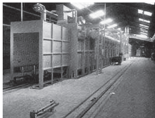
図 3.35 トンネルキルンの外観 1)
