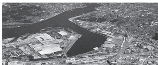
図 4.36 平成 21 年の北九州市八幡東区 (八幡製鐵所 100 年史より)
