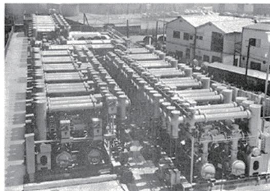
図 3.42 関西電力南大浜開閉所納 84 kV 主母線三相一括相分離 GIS (1971) (掲載許諾) 21)
