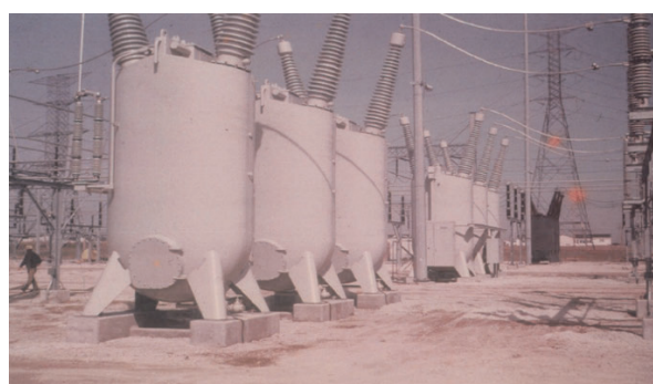
図 2.20 米国 WH 社製 345 kV-63 kA 節油タンク形油遮断器 5), 23)
