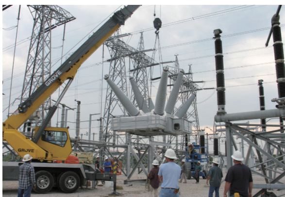
MEPPI 製 362 kV-63 kA 三相一括ばね操作遮断器の据付状況 (2002)
