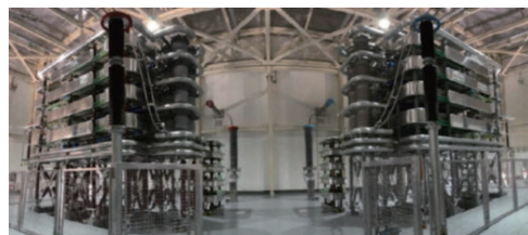
図 4.31 中国国家電網張北変換所納ハイブリッド方式直流遮断器 26), 42)
