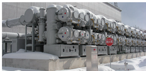
図 3.51 北海道電力泊原子力発電所納三菱電機製 300 kV 主母線三相一括相分離形 Full-GIS 一点切ばね操作 CB 適用 (2006) (掲載許諾) 23)
