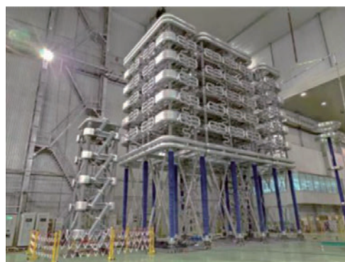
図 4.32 中国 535 kV-26 kA ハイブリッド方式直流遮断器 27), 42), 44)
