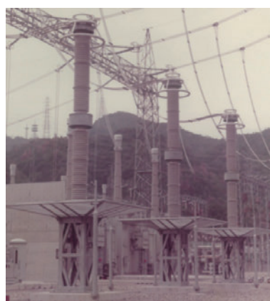
図 3.6 関西電力西播磨変電所納三菱製 550 kV 碍子形酸化亜鉛形避雷器(1979)(掲載許諾)
