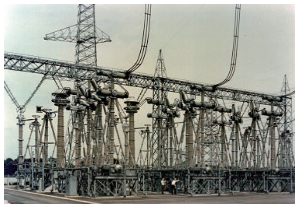
図 2.34 東京電力房総変電所納東芝製 550 kV-50 kA 空気遮断器 (1971) (東芝提供)
