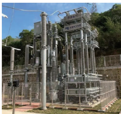
図 4.30 強制発振電流零点形成方式の 160 kV-9 kA 機械式直流遮断器 (2013) 26), 43)
