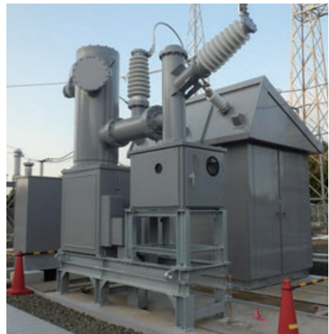
図 4.28 電源開発新北変換所納東芝製 MRTB (2019) (掲載許諾) 36)
