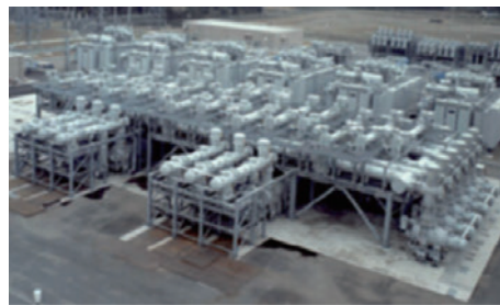
図 3.62 東京電力新野田変電所納東芝製 550 kV 相分離形 Full-GIS (1981) (掲載許諾)
