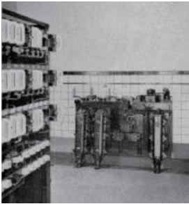
図 3.35 12 kV-100 MVA 油絶縁開閉装置 (1935) (TenneT 提供) 19), 20)
