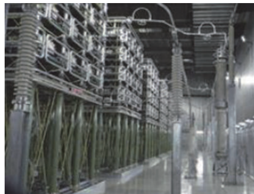
図 4.8 新北本連系自動式 IGBT 変換装置 (2019) (掲載許諾) 22)
