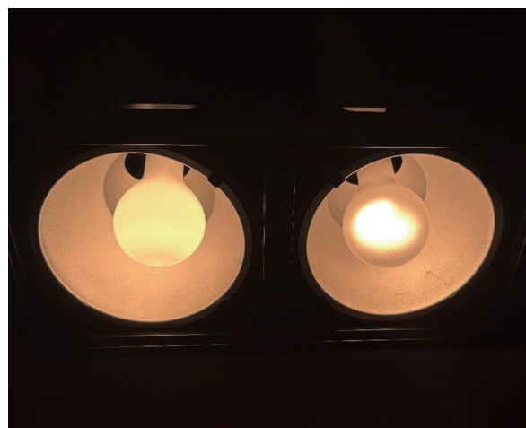
図 5.2 LF 電球（右）と LW 電球（左）の違い
