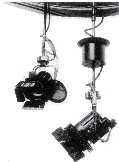
図 8.19 NHK の CT-101 スタジオに導入された 5 kW テレビスタジオ向けリモートコントロールスポットライト(株式会社龍電社)
