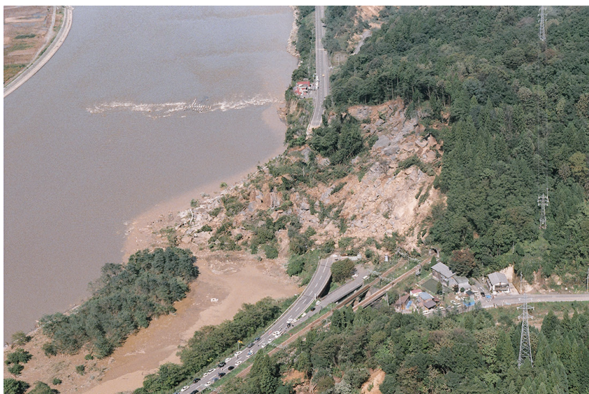
図 4.41 親子が巻き込まれた土砂崩落現場（東京消防庁提供）
