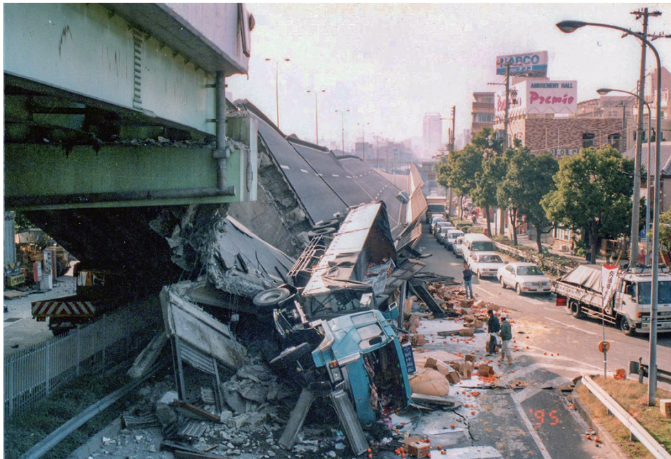
図 4.34 阪神・淡路大震災の被害 (写真提供：神戸市) (神戸市、阪神・淡路大震災「1.17 の記録」 https://kobe117shinsai.jp/ )
