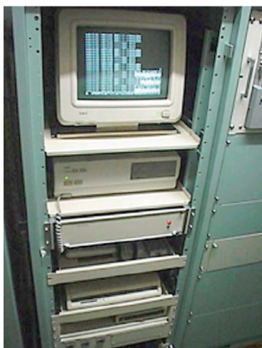
図 4.22 青函トンネルユレダス 4-18) (掲載許諾)
