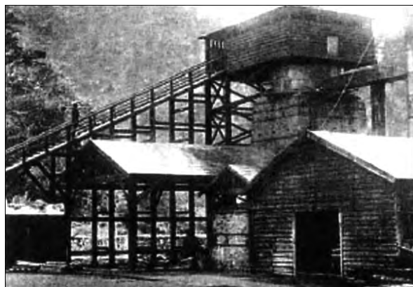
図 3.5 49 回目の試製で成功した第1高炉 13)
