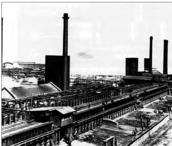
図 4.7 ソルベー余熱式コークス炉
