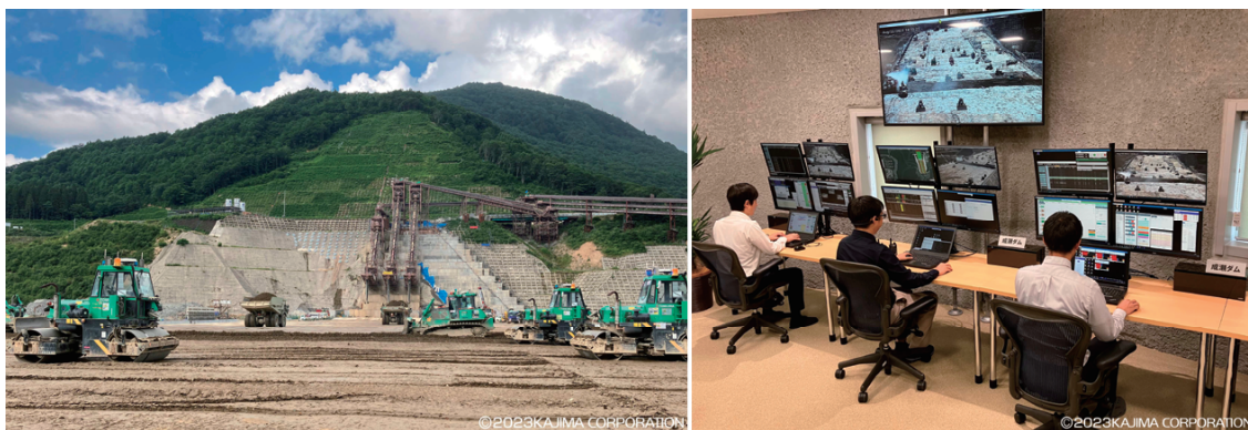
図 6.4 成瀬ダム秋田県の工事現場と神奈川県の管制室 (写真提供：鹿島建設株式会社)
