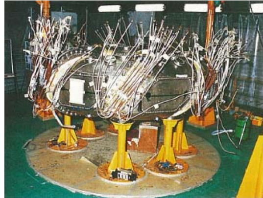
写真 6. 完成時のヘリカルコイル巻線 (日立製作所提供)
