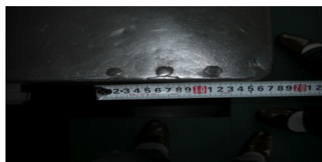
写真1 シンク部の釘止め使用例
