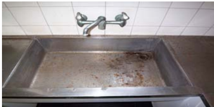
写真3 シンク部に生じた錆び
