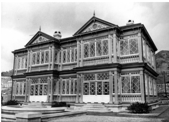
図1 ハンター邸(旧ハンター邸移築工事報告書より)
