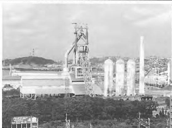
〔スライド5〕 東田第一高炉(改修前)
