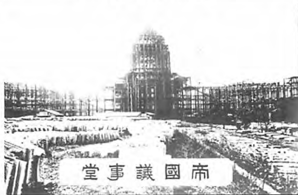
〔スライド3〕 建設中の国会議事堂
