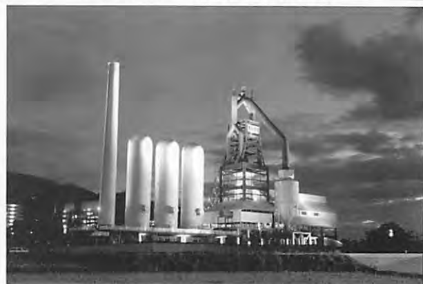
〔スライド7〕 東田第一高炉(改修後)
