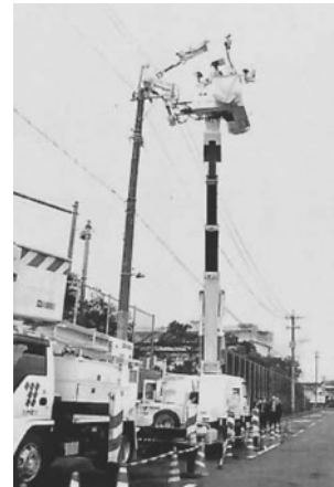
写真5.18 「配電線工事ロボット」
