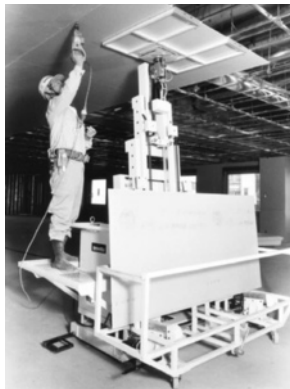
写真5.4 「天井ボード貼りロボット」
