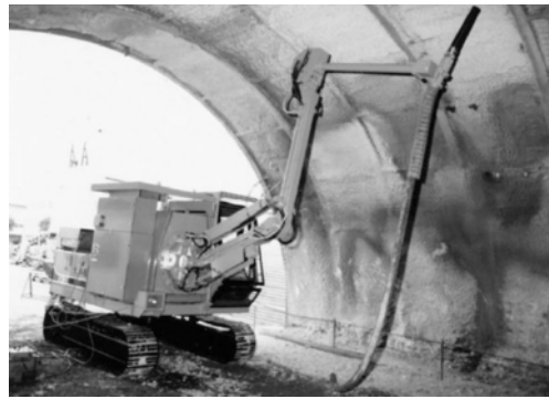
写真5.11 「コンクリート吹き付けロボット」
