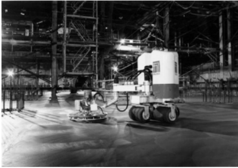
写真5.3 「コンクリート床直仕上げロボット」
