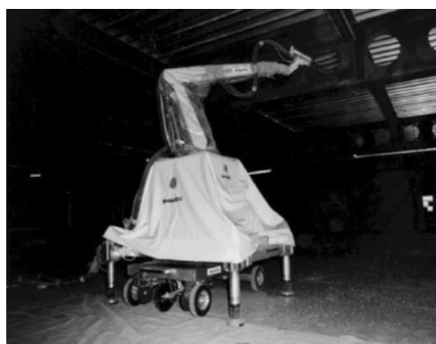
写真5.1 「鉄骨耐火材被覆ロボット」
